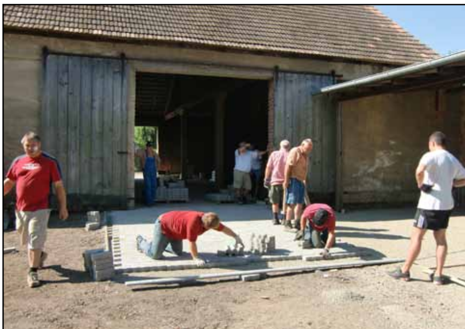
Mühsame Arbeit bei der Pflasterung der Auffahrt zum Dorfstadl
