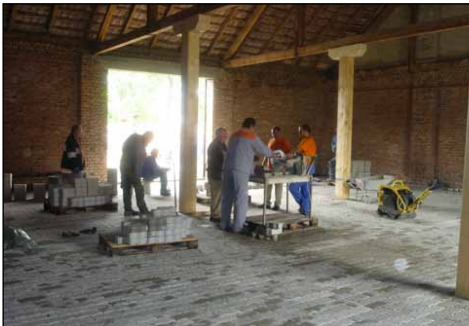
Die Pflastersteine für 255 m 2 konnten in nur einem Tag verlegt werden
