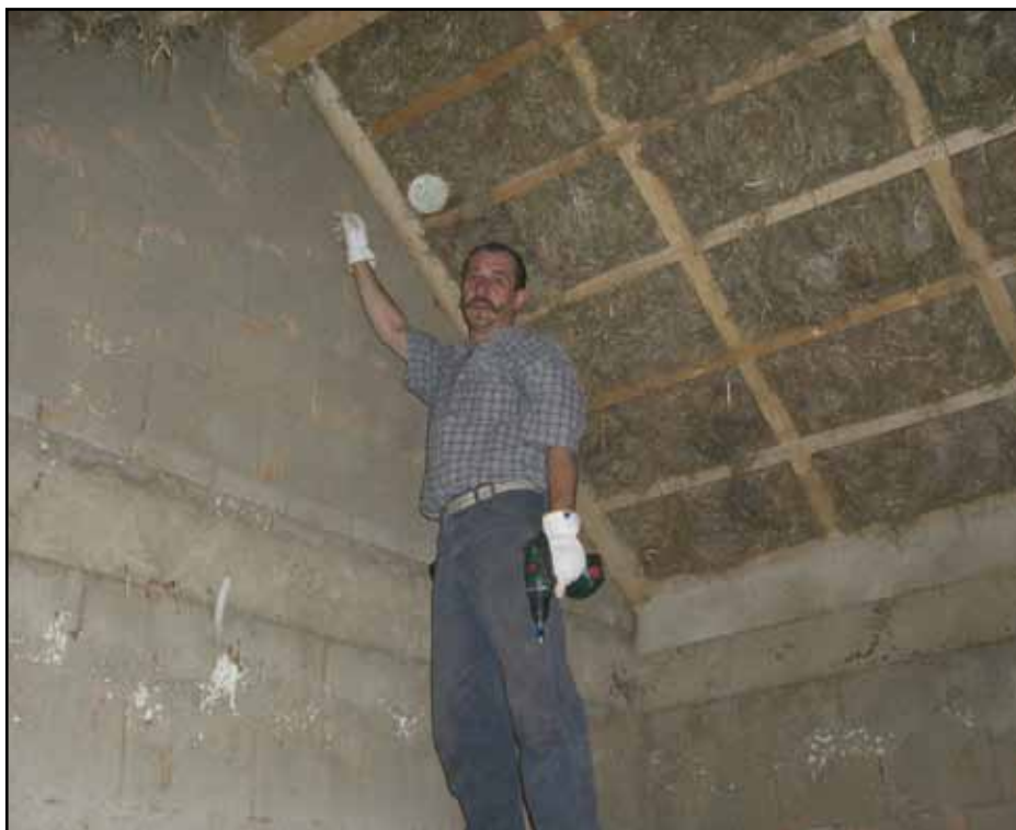
Isolierung der Dachschräge mit Hanf-Stopfwolle.
