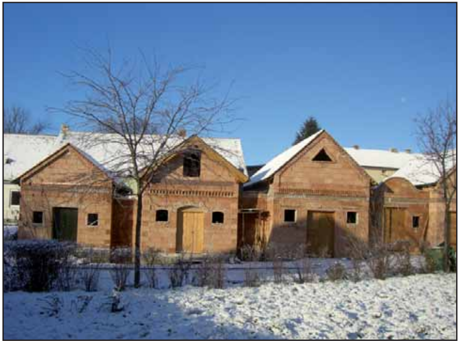
Kellerensemble – Im Rohbau bereits ein gelungenes Werk.
