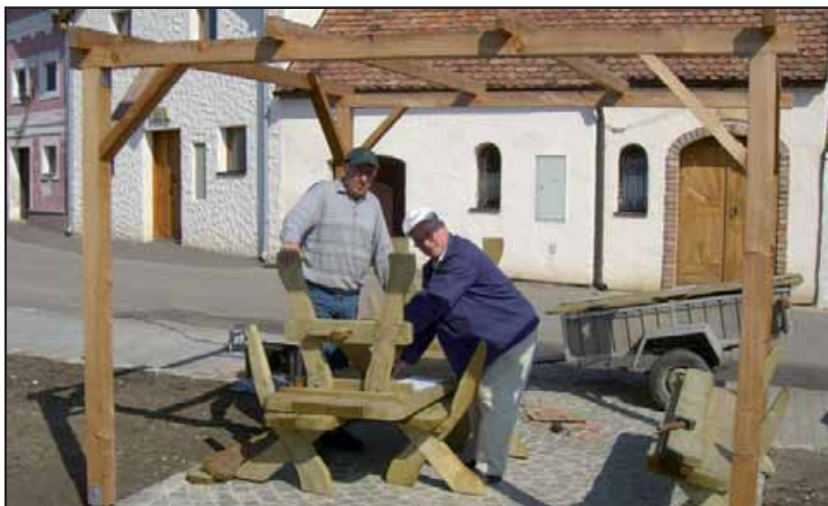
Letzte Arbeiten bei der Fertigstellung der Keller-Laube.
