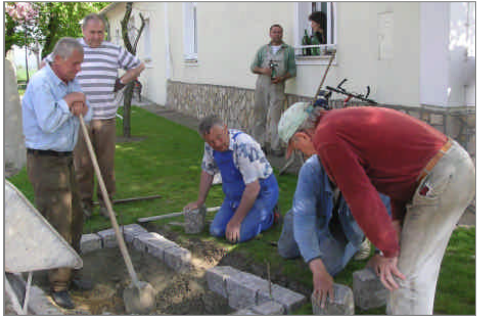
Unter der Leitung von Polier Anton Rogler wurden die Randsteine versetzt
