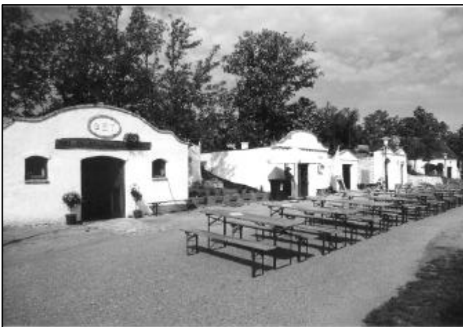
Die Keller beim Trinkbrunnen wurden allesamt behutsam nach alter Kellerarchitektur neu errichtet oder instandgesetzt.
