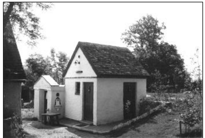
Der Gemeinschaftskeller und das Kölla-Häusl oder Schmunzel-Klo fügen sich harmonisch in die revitalisierte Kellergasse am Brunn-Beri.
