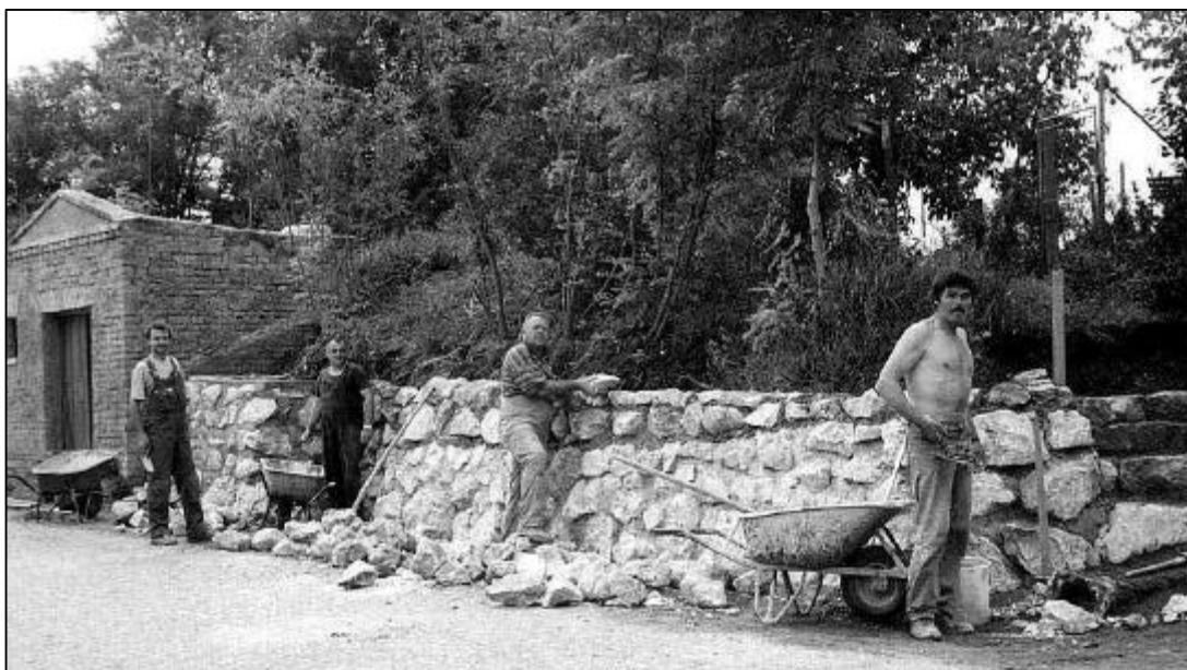
Die Böschungsmauer zielt nun das Keller-Viertel beim Trinkbrunnen.
